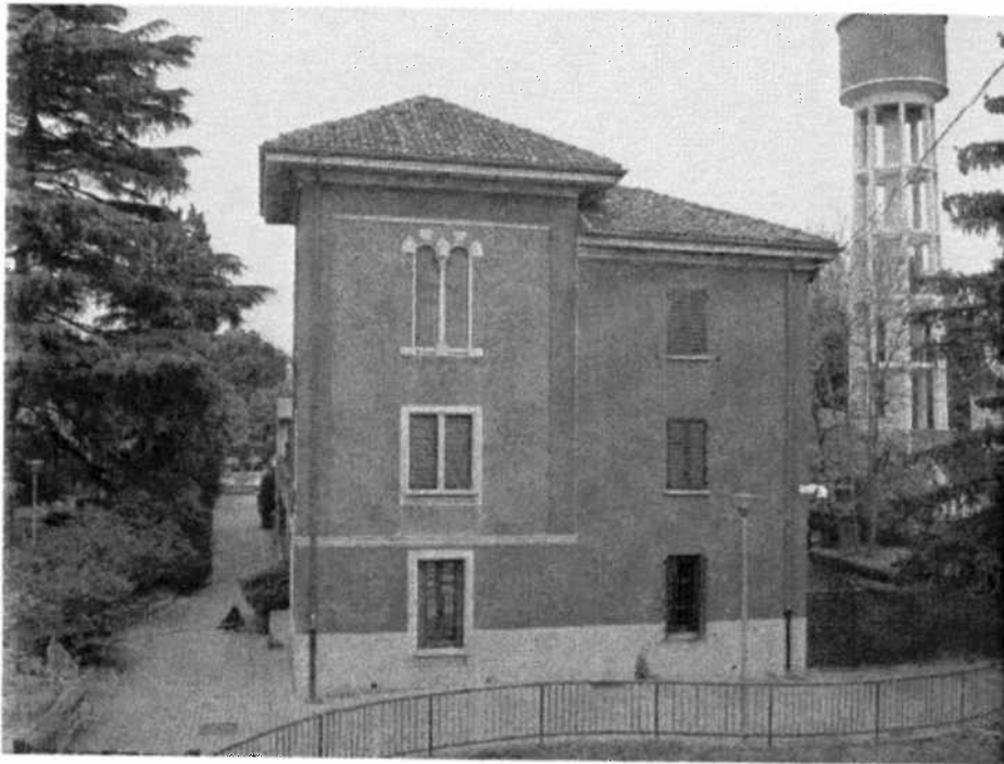
Fig. 1 Edificio oggetto d'intervento – prospetto sud-est
