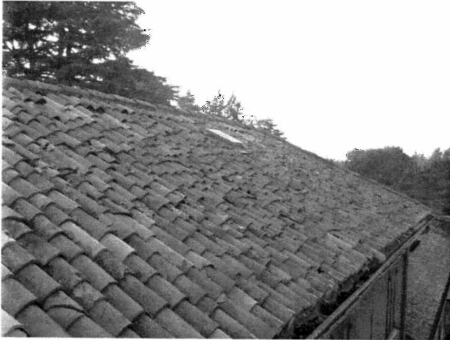
Fig. 9 Particolare distacco di alcuni coppi in gronda
