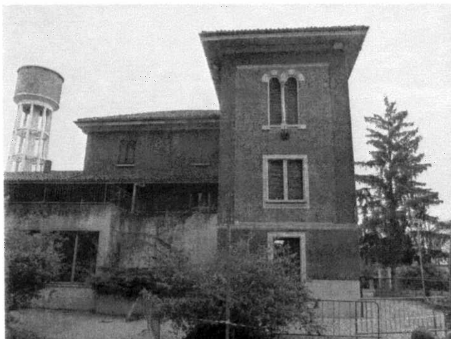
Fig. 3 Edificio oggetto d'intervento – prospetto sud-ovest
