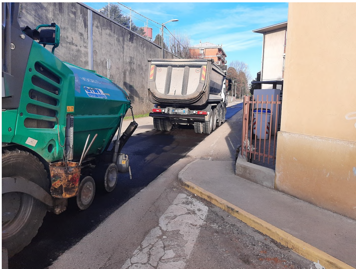
Via De Gasperi – Ripristino provvisorio pavimentazione stradale – 2 febbraio 2023
