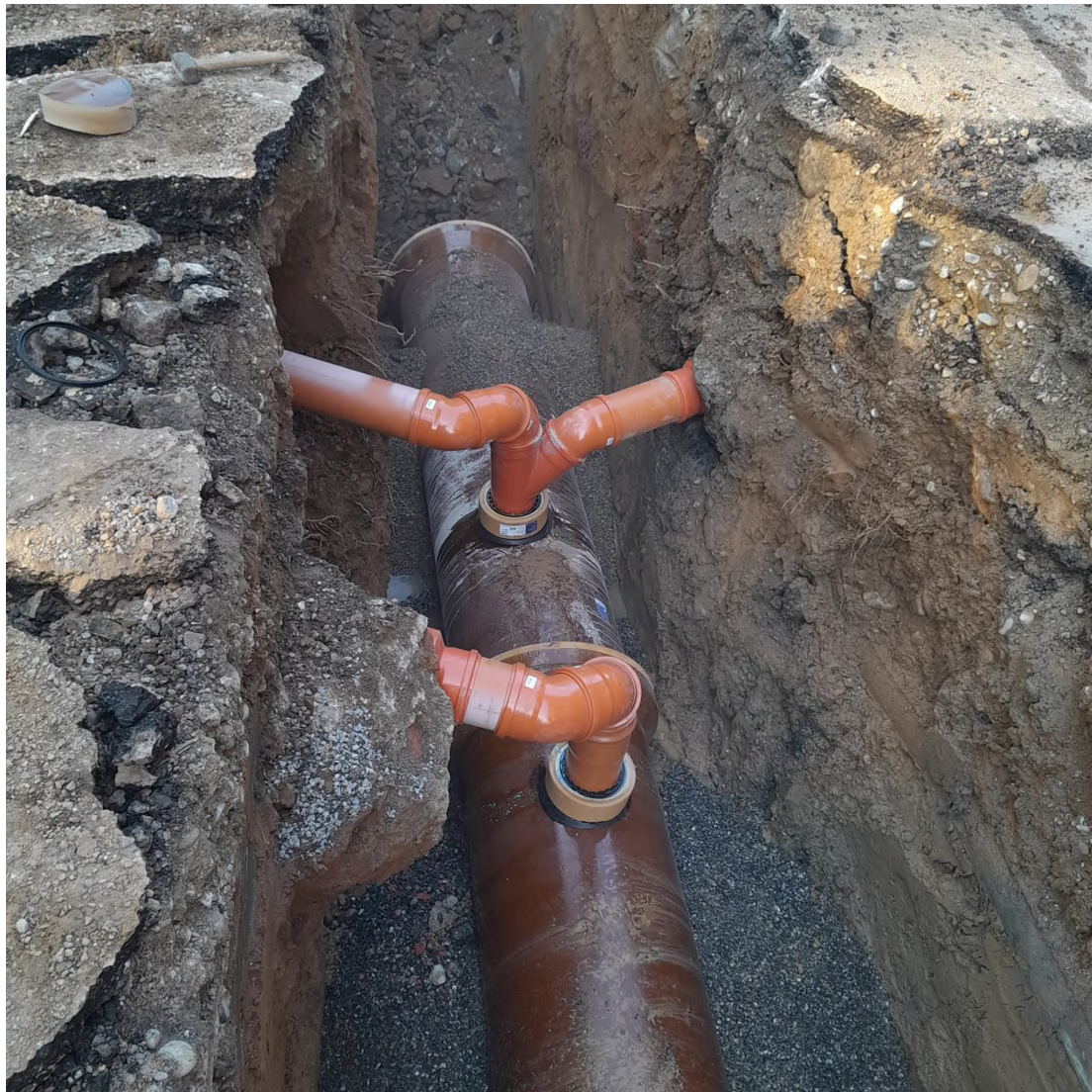
Via De Gasperi – Posa fognatura gres – 31 gennaio 2023
