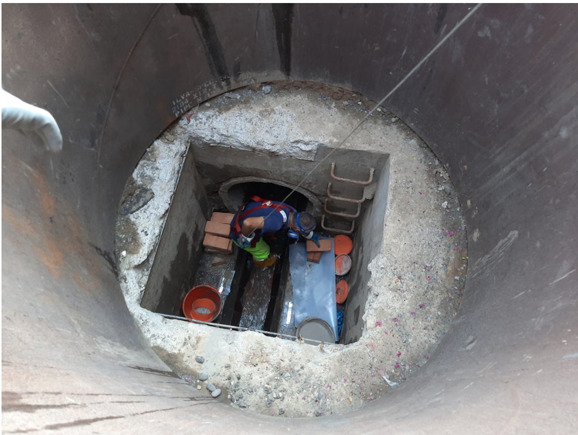
Via Vittorio Veneto – lavorazioni preparatorie per il risanamento senza scavo del collettore fognario – 20 luglio 2023
